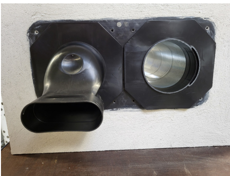
Kuva 3. Tarkista ennen kanavien asentamista paikalleen, että eriste on tiiviisti adapteria vasten ja selvitä, kummalle puolelle läpivientä ulko- ja jäteilmakanavat tulevat. Asenna kanavat kuvan mukaisesti niin, että seinäläpiviennin etulevyn ruuvireiät jäävät näkyviin.
