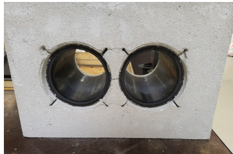
Kuva 2. Rappaustulpat poistettu. Seinäläpiviennin suojaputket ja ruuvinreiät näkyvät. Asenna seuraavaksi IO-seinäläpiviennin lisäpaketti ja IO 125-päätelaitte.
