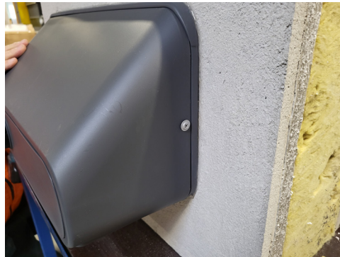
Kuva 9. Lukitse kansi kiinni molemmilta puolin ruuveilla.
