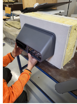
Kuva 7. Asenna päätelaitteen kansi. Laita ensin yläosa paikoilleen. Työnnä sen jälkeen alaosaa, kunnes se naksahtaa paikoilleen.
