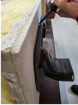
Kuva 5. Laita tiivistysmassaa kehyksen taakse, yläpuolelle ja molemmille sivuille.
