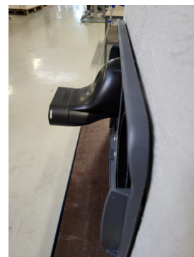
Kuva 4. Asenna asennuskehys. Älä kiinnitä ruuveja pohjaan asti, vaan jätä ne löysälle, kunnes tiivistysmassa on levitetty.
