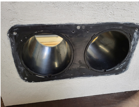
Kuva 1. Sandwich-elementeissä seinäläpiviennin suojaputket ja etulevy ovat näkyvillä.
